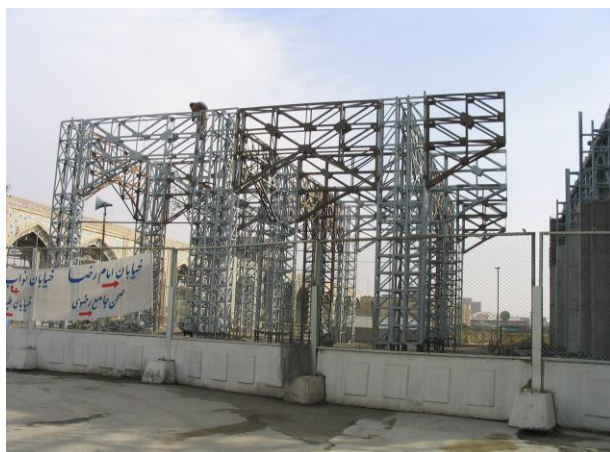
شکل (۴): بخشی از سازه رواقهای فلزی - سمت راست سیستم سازه قابی - سمت چپ سیستم خرپای سبک
