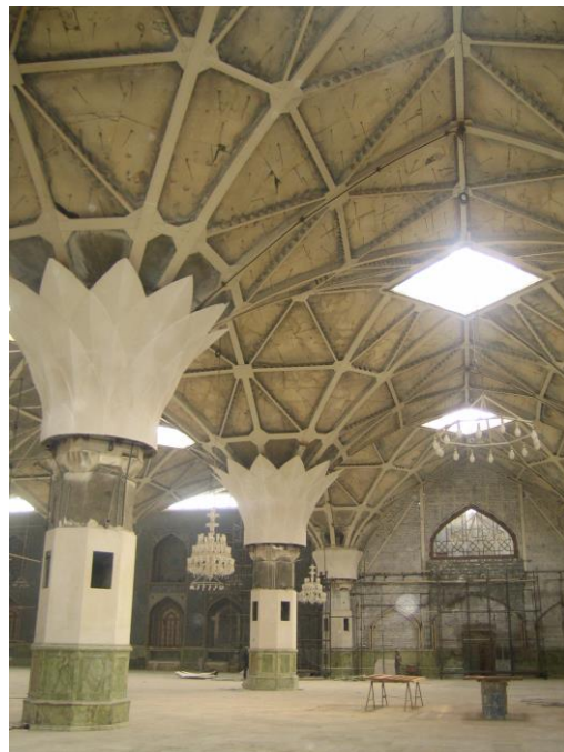
شکل (۸): المانهای قوسی فلزی در حین مونتاژ در تصویر سمت چپ و پس از اتمام سازه در تصویر سمت راست نمایش داده شده اند
