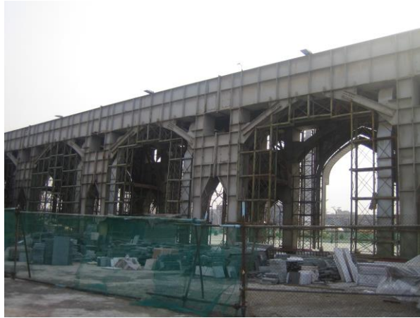
شکل (۳): بخشی از سازه رواق فلزی صحن جامع رضوی
