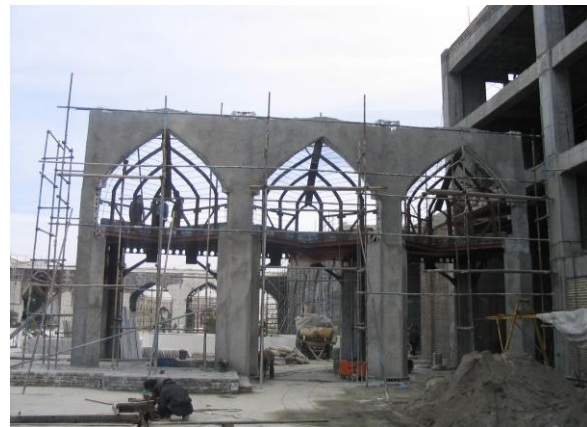
شکل (۶): بخشهایی از سازه رواق فلزی بست غربی و شرقی
