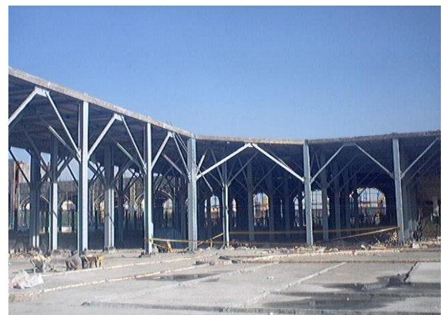
شکل (۴): بخشی از سازه رواقهای فلزی - سمت راست سیستم سازه قابی - سمت چپ سیستم خرپای سبک
