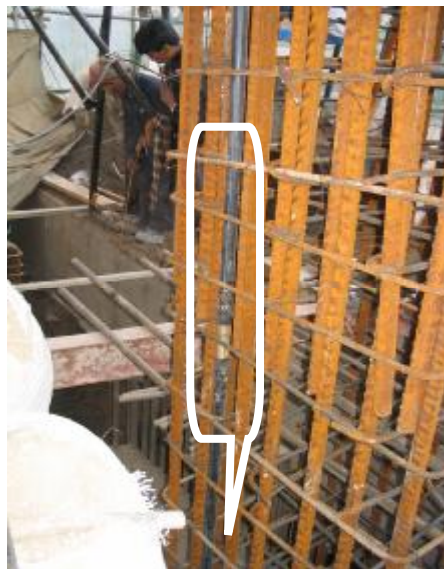
شکل (6) - نصب کشیدگی سنج در قفس میلگرد شمع
